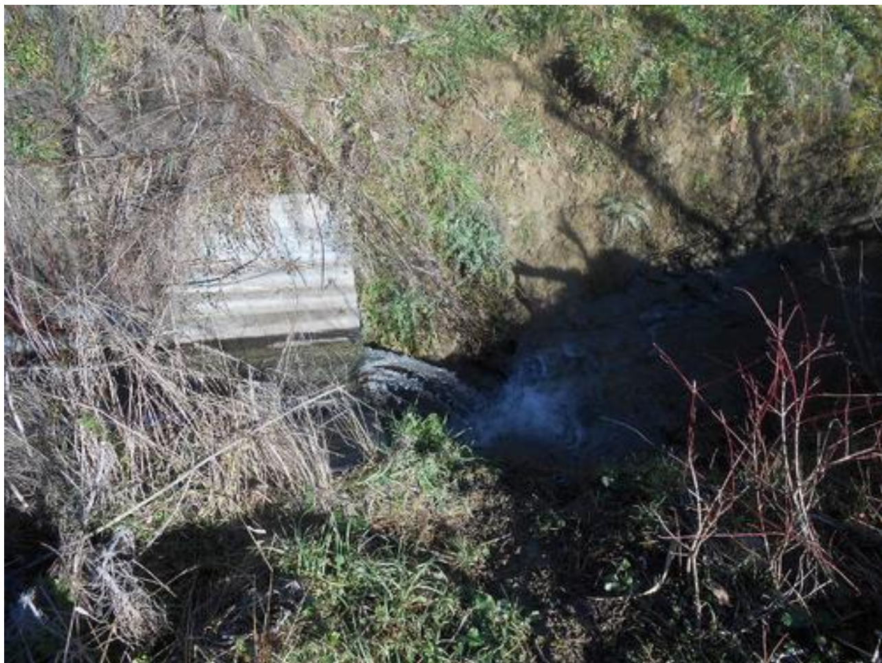
Foto 2: canaletta zincata di scolmo delle acque meteoriche e di drenaggio terreni agricoli in uscita dai bacini artificiali
